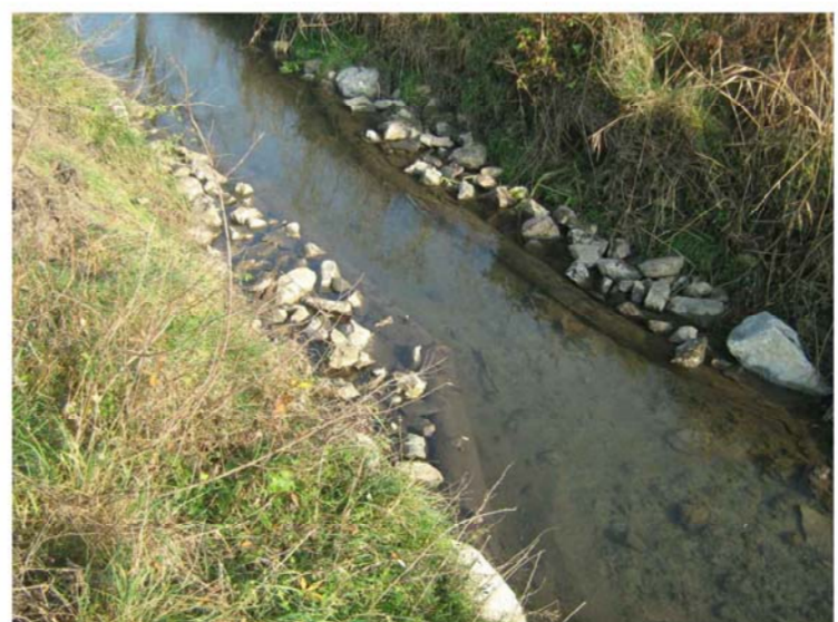
Realizzazione di costrittore
